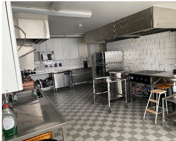
Kuva 27. Keittiössä välipohjan pintarakenteena on keraaminen laatta
