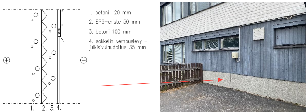
Kuva 23. Sokkelirakenne rakennuksen eteläpuolella
