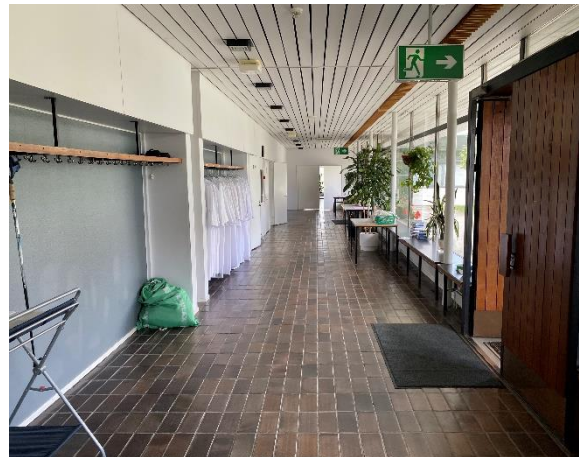
Kuva 28. Sisäntuloaulan alueella välipohjan pintarakenne on keraaminen laatoitus
