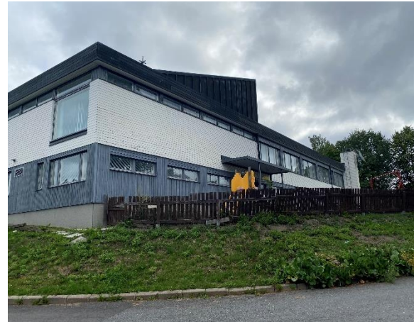
Kuva 21. Rakennuksen räystäät ovat kapeat. Alemmassa kerroksessa ulkoseinät ovat puuverhotut, ylemmässä tiiliverhotut
