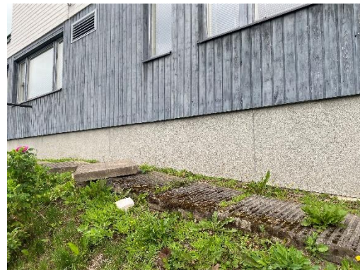
Kuva 14. Sokkeli on etupihaa lukuun ottamatta verhottu sirotepintaisella verhouslevyllä
