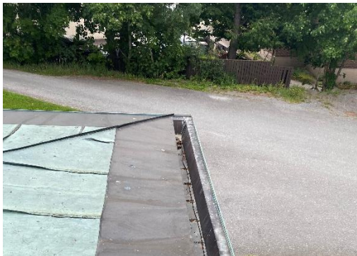
Kuva 32. Vesikatetta on uusittu räystäällä noin puolen metrin matkalla koko seurakuntasalin vesikaton osuudella
