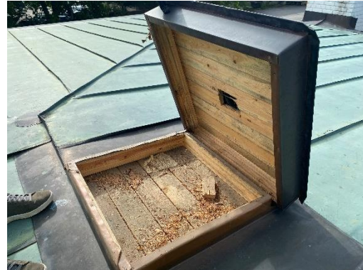
Kuva 31. Yläpohjan tarkastusluukun alapuolella on välittömästi vesikaton aluslaudoitus. Luukun kannessa on reikä alipainetuulettimelle.
