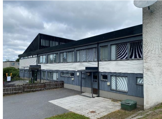
Kuva 12. Yleiskuvaa etelän puoleisesta julkisivusta piha-alueineen
